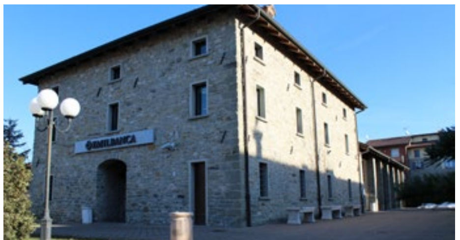
La sede di Emil Banca a Cavola, sull'Appennino reggiano, che da qualche anno ospita anche due sezioni del nido del paese in attesa della sistemazione della scuola. In passato, i locali sono stati offerti anche alle scuole elementari rimaste senza aule a causa di danni strutturali all'istituto scolastico
